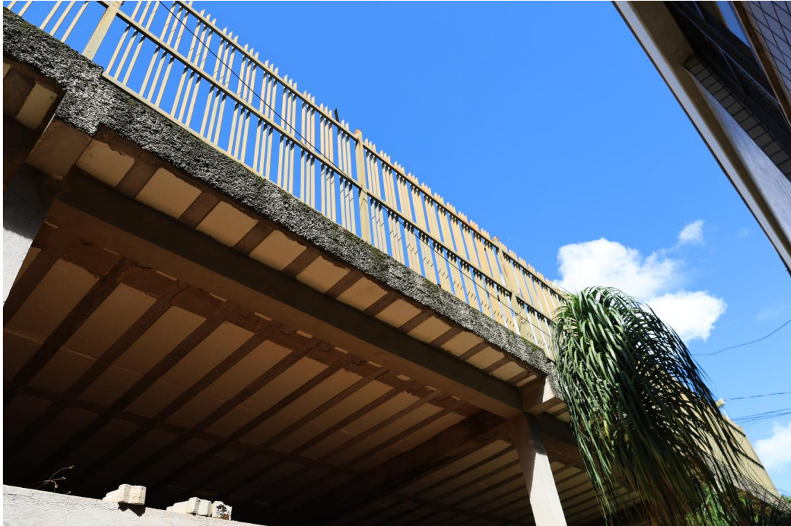
Figura 5.18 Grades internas do estacionamento superior – altura do solo ~ 6 metros; 45 metros de comprimento linear de grades
