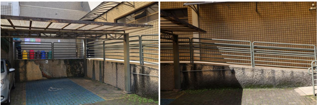
Figuras 5.13 a-b Guarda-corpos e corrimões tubulares do estacionamento dos vereadores
