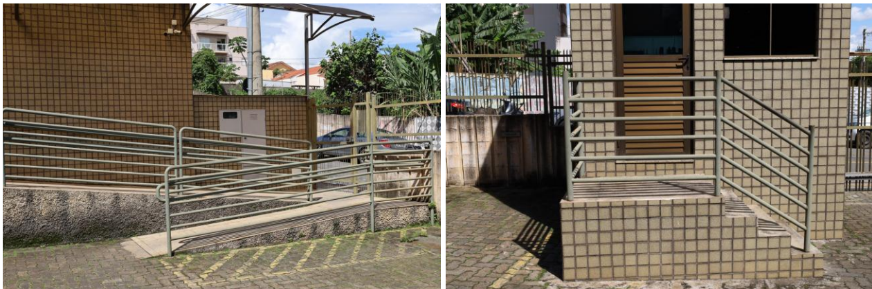
Figura 5.14 a-b Detalhes dos guarda-corpos do estacionamento dos vereadores; rampa de acesso e escada da guarita
