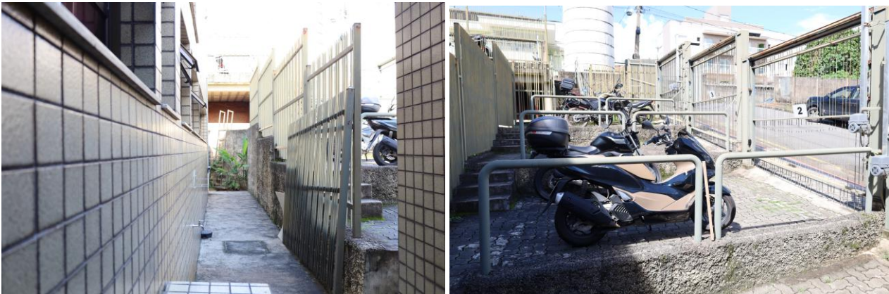
Figura 5.16 a-b Divisões internas do estacionamento lateral para motos; grades e guarda-corpos tubulares
