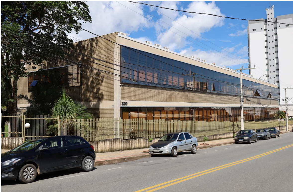
Figura 5.11 Vista das grades – Av. São Francisco
