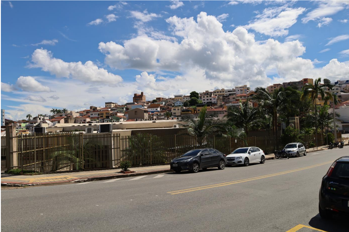
Figura 5.8 Vista das grades, Av. Belo Horizonte. Notar as palmeiras do jardim abaixo das grades
